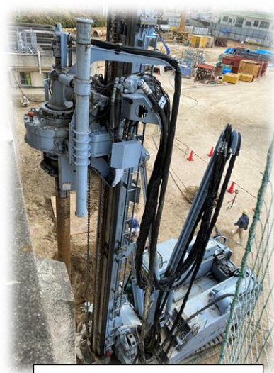
基礎設置工事
