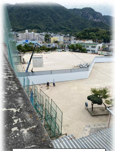
グラウンド枠囲い
