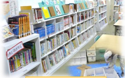
③図書室本棚修繕
