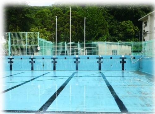
きれいになったプール
