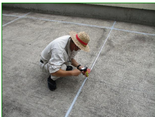
2階の屋上補修をしてくださる平澤先生 1
