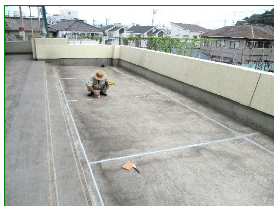
2階の屋上補修をしてくださる平澤先生 2
