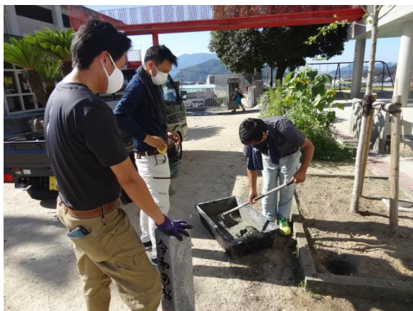
コンクリートをしっかり練っています
