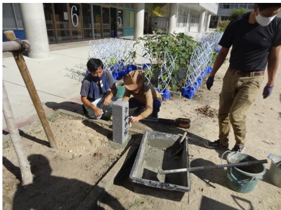
職人技で、高さ等の調整をしていました
