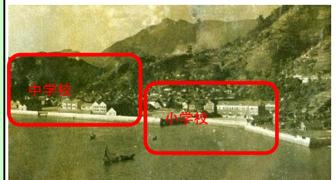
昭和27年(1952)頃 長浜小・中の全景
