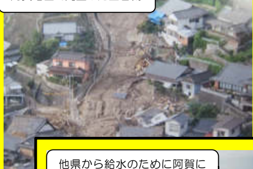
阿賀地区で発生した土石流
